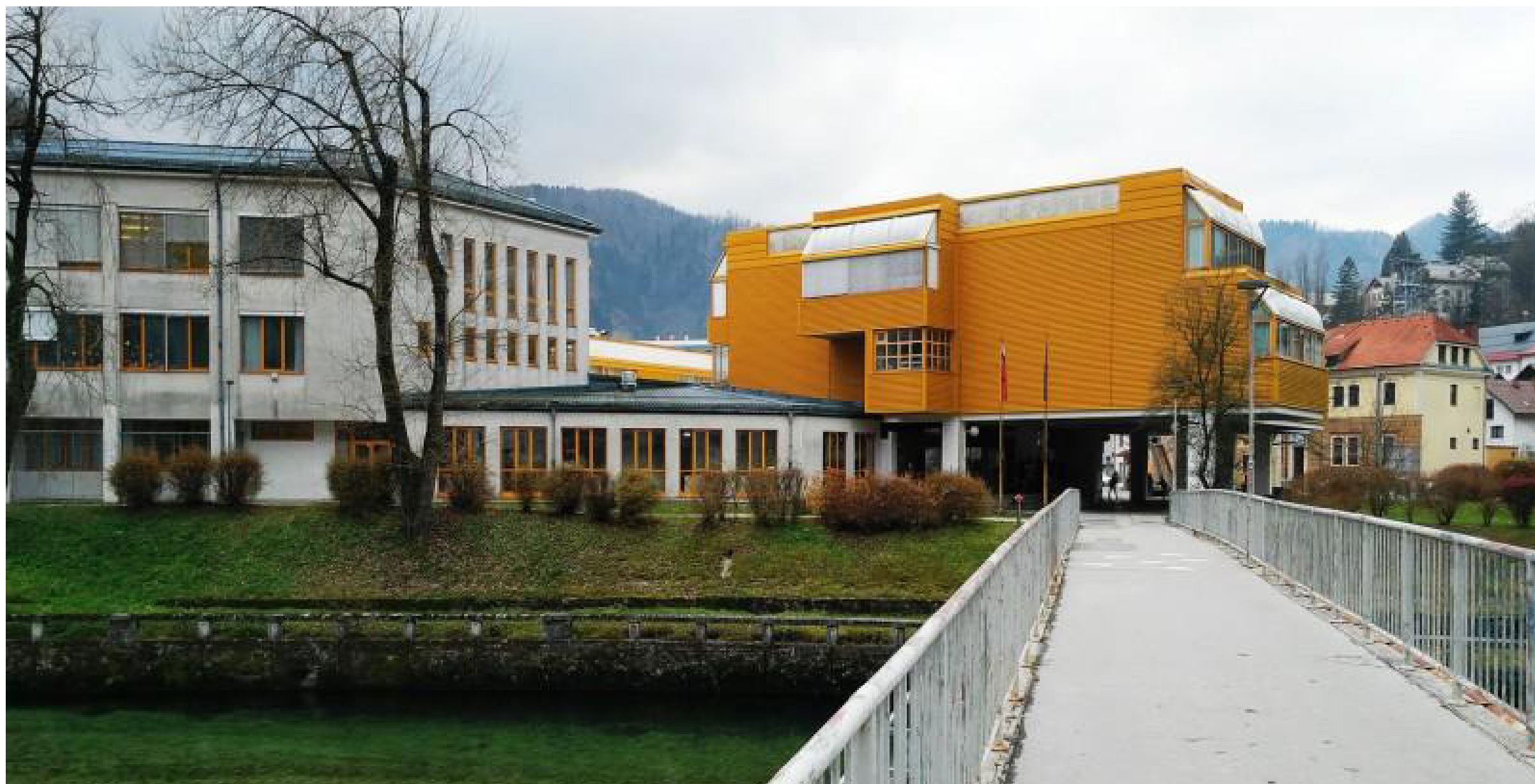
Pešpot, ki se vije pod nadstreškom šole, se nadaljuje čez reko Idrijo proti novejšemu delu mesta. (vir: https://www.nekteo.eu/sl/energetsko-vzor%C4%8Dne-to%C4%8Dke/slovenija/osnovna-%C5%A1ola-idrija , dostop 16.9.2019)
